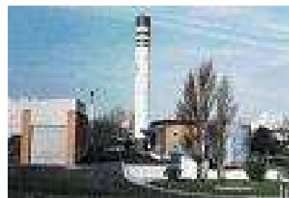
Chaufferie bois et centrale de cogénération à Calais
